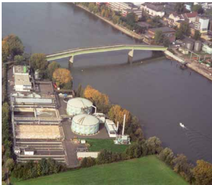
Luftbild der ursprünglichen Abwasserbehandlungsanlage auf der Rheininsel Petersaue
