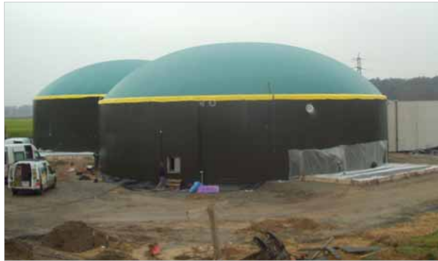
Im Bau befindliche Biogasanlage der HSE in Darmstadt-Wixhausen
