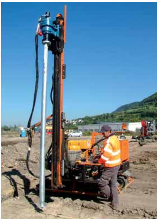
Eindrehen eines Bohrfundaments
