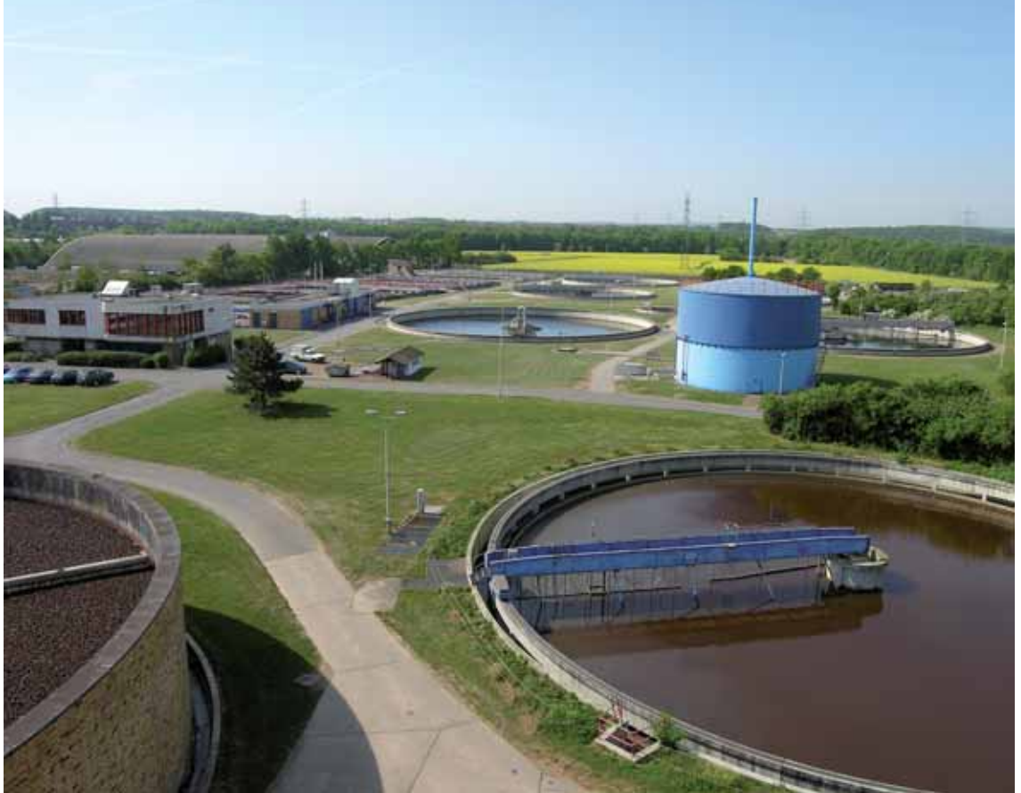
Die Kläranlage in Gießen bietet große Potenziale zur Abwärmenutzung.
